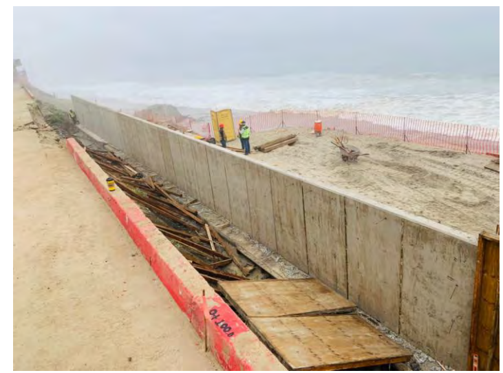
0+000 a 0+300 Terracerías, pilotes y muro de contención
